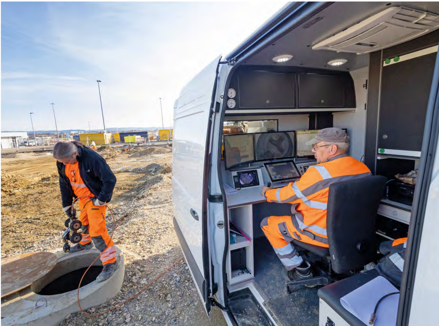
Mit moderner Technik tief in die Kanäle: Um Schäden unter der Erde sichtbar zu machen, werden moderne Kamerasysteme genutzt. So verhindern wir, dass aus kleinen Defektengroße Ausfälle werden.
