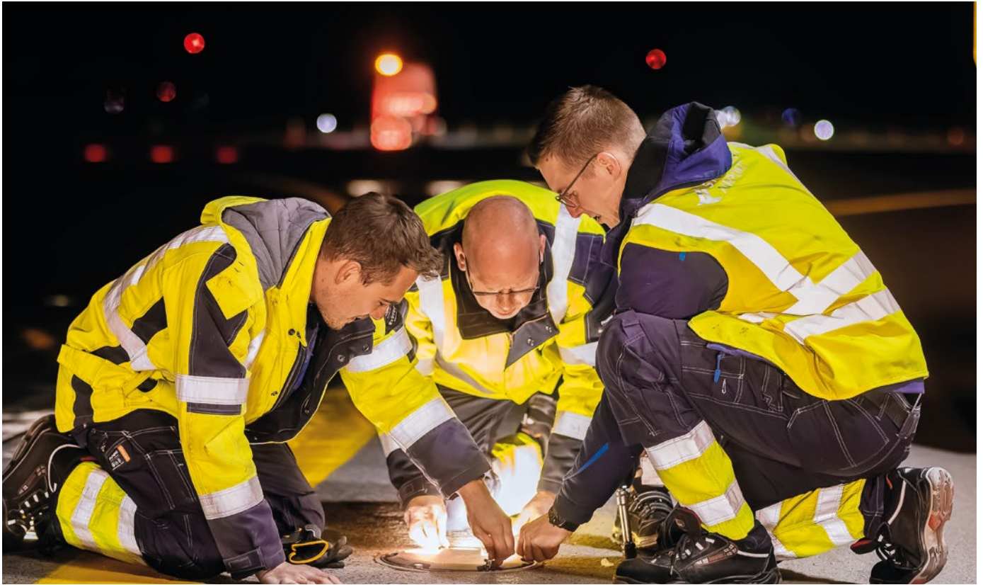
Energiemanagement am Flughafen ist eine herausfordernde Aufgabe. Wo immer möglich, setzt der Landesairport auf stromsparende LEDs – auch seine Runway beleuchtet er damit.
